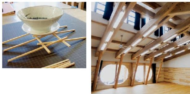
図7 めり込みを活かした支点桁構法
