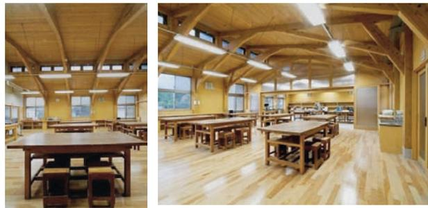
図6 めり込みを活かした樹上平面トラス架構
