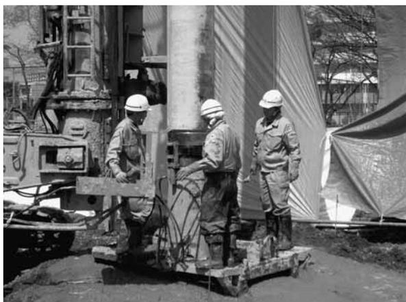
杭を継ぐ施工方法は、「溶接」と「機械式継手」があります。溶接は、雨の日や、風の強い日にはできません。また、溶接箇所の清掃も現場では問題が多くあります。そこで、私の設計では、機械式継手で設計します。機械式継手の方法も、ボルトで継ぐ方法や、鋼製のリングで締めていきながら継いでいく方法などがあります。写真の今回の現場では、機械式継手で、鋼製リングにより、杭を継いでいます。
