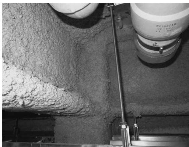
鉄骨の柱と梁に防火材を吹き付けた例
